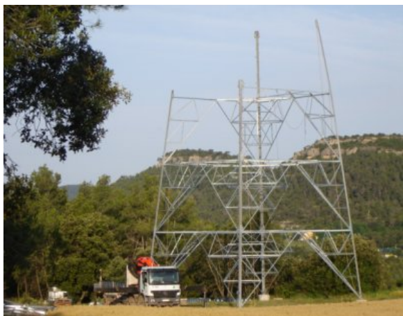
Inici construcció torre 37 MAT al Mas Blanc: 29 juny
